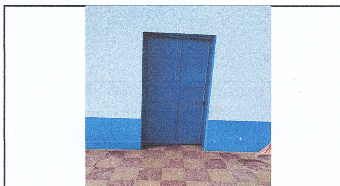
Remozamiento de puertas y cambio de chapas
