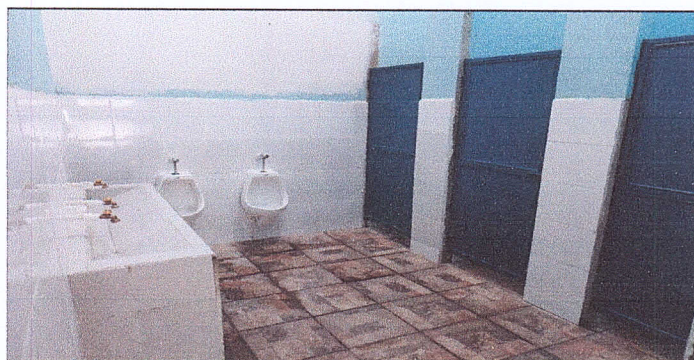
Sustitución de azulejo de los baños y cambio de puerta.
