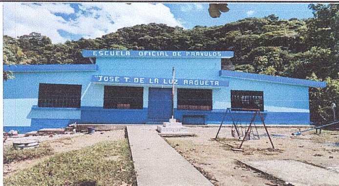
Pintura en muros exteriores e interiores
