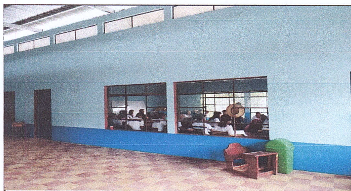
Pintura de muro interior
